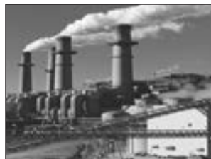
Planta generadora de energía eléctrica (© Vol. 57/PhotoDisc)
