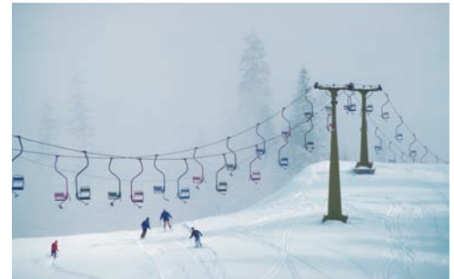
Fotografía 7.3 Como el peso del cable del transporte para esquiadores que se muestra en la foto es despreciable comparado con el peso de las sillas y los esquiadores, los métodos de esta sección pueden usarse para determinar la fuerza en cualquier punto del cable.
