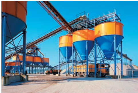
Fotografía 5.2 Todos los tanques de almacenamiento que se muestran en la fotografía son cuerpos de revolución. Por tanto, las áreas de sus superficies y sus volúmenes pueden determinarse con los teoremas de Pappus-Guldinus.
