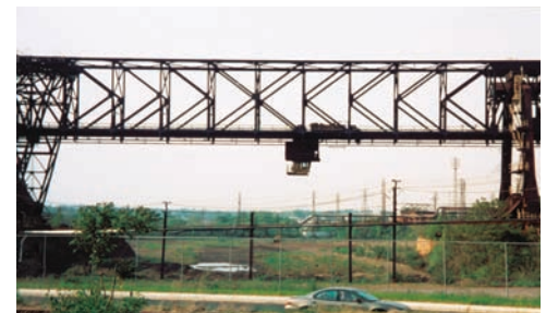
Fotografía 6.2 Dos armaduras K se usaron como los principales componentes del puente móvil que se muestra en la foto, el cual se movía por encima de un gran montón de mineral de reserva. El cubo que se encuentra debajo de las armaduras levantaba mineral y lo repositaba hasta que el mineral estuvo completamente mezclado. Después, el mineral se envió al molino para incorporarlo a un proceso de producción de acero.
