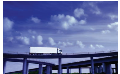
Fotografía 7.2 Las fuerzas internas en el paso a desnivel varían conforme el camión lo cruza.
