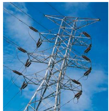
Fotografía 6.4 Las armaduras tridimensionales o espaciales se usan para las torres de transmisión de energía eléctrica y señales en estructuras de techo y para aplicaciones a naves espaciales, como en los componentes de la Estación Espacial Internacional .
