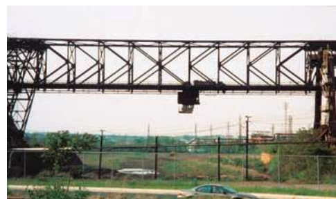
Fotografía 6.2 Dos armaduras K se usaron como los principales componentes del puente móvil que se muestra en la foto, el cual se movía por encima de un gran montón de mineral de reserva. El cubo que se encuentra debajo de las armaduras levantaba mineral y lo redepositaba hasta que el mineral estuvo completamente mezclado. Después, el mineral se envió al molino para incorporarlo a un proceso de producción de acero.
