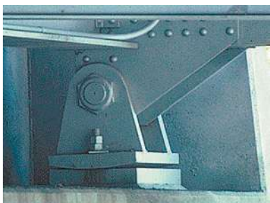
Fotografía 4.4 El apoyo oscilatorio del estribo montado, que se muestra en la fotografía, se usa para apoyar el camino sobre un puente.
