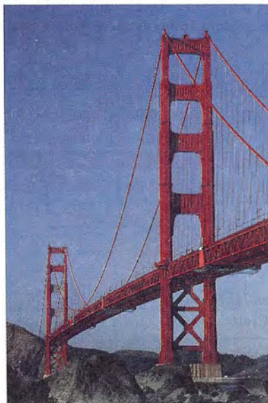
Figura 6.19 El puente Golden Gate (California) tiene un claro central colgante de 1280 m (4200 pies) de longitud.
